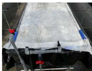
⑤ 防根シート を敷く。
