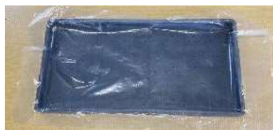
② 止水シートなどを敷き排水穴をすべて塞ぐ。
