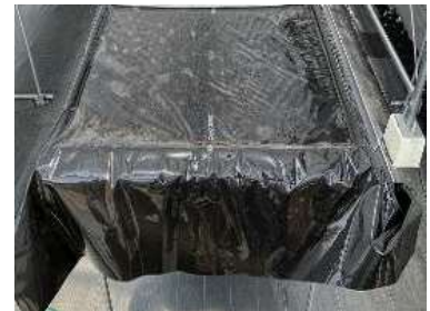
③ 止水シート を敷いて、水を溜められるようにする。
