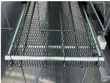
① エクspandメタル のベンチを設置する。
